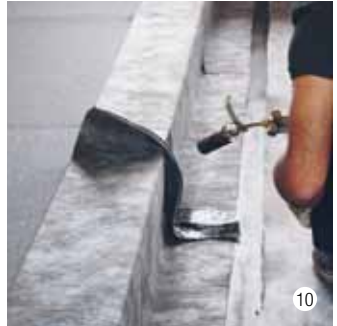
Flammfolie abflämmen und verschweißen.
